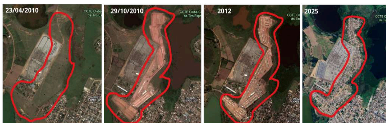
Figuras 32 - Processo de construção do Conjunto Habitacional Aldeia II
