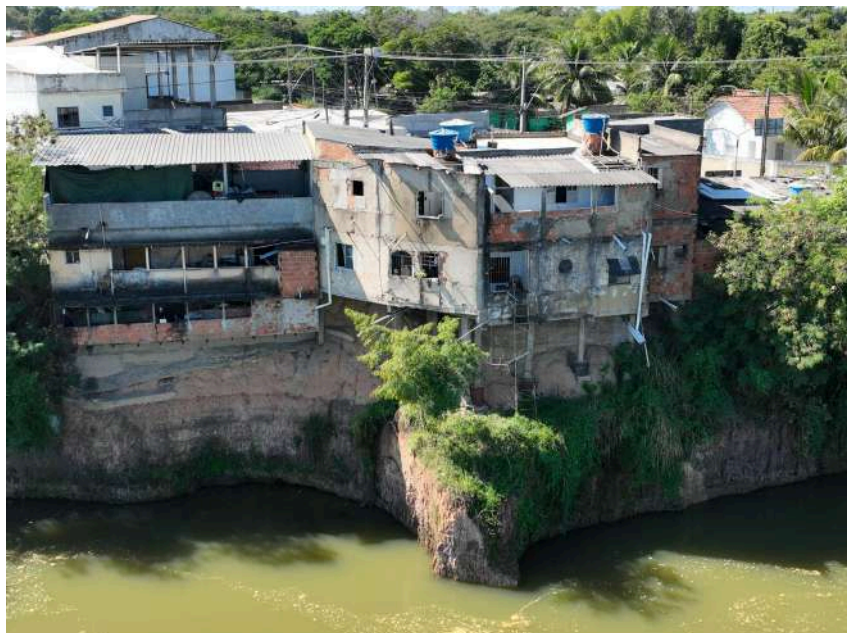
Figura 44 - Vista da estrutura das construções da FCU Fundão
