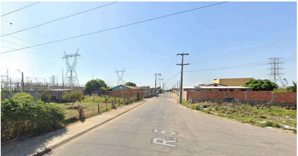
Figura 36 - Proximidade das residências do conjunto com a torres de alta tensão de FURNAS
